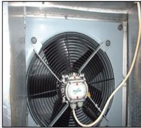
Después de Green Blasting
